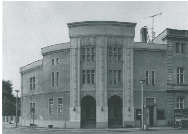
Straßenfassade, um 1990, BLDAM
