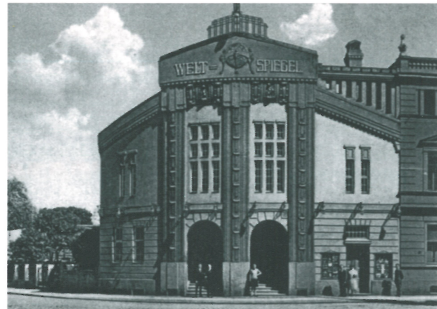
Straßenfassade, 1911, Archiv Ralf Zarnoch
