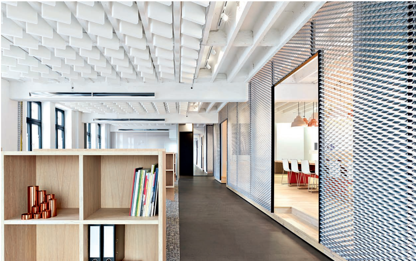
Ebenfalls dynamisch wirkt die Decke mit den diagonal und in Serie abgehängten Baffeln aus Akustikschaumstoff. • The ceiling with the diagonal and in series suspended baffles of acoustic foam also looks dynamic.
